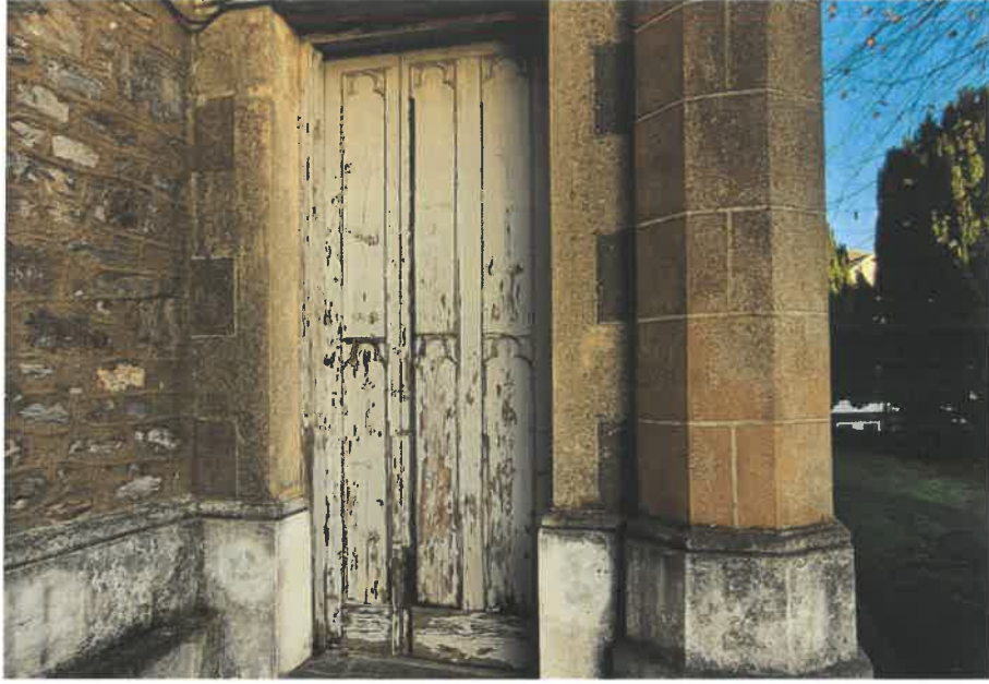
29 Door D3 – Porch
