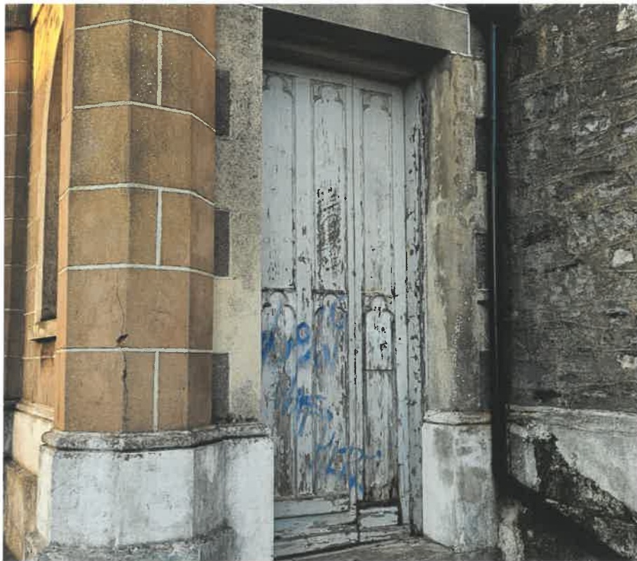
30 Door D4 – Porch
