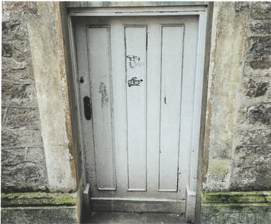
28 Door D2 – Stairs
